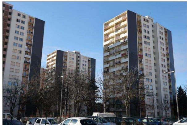
Les immeubles du 1 et 3 rue de Paris tels qu'ils se présentent aujourd'hui. Photo L'Alsace/Hervé KIELWASSER
