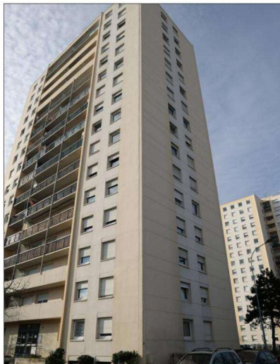
Au fil du temps, ces immeubles, construits entre les années 1960 et 70, étaient devenus de véritables passoires thermiques. Photo L'Alsace/Hervé KIELWASSER
